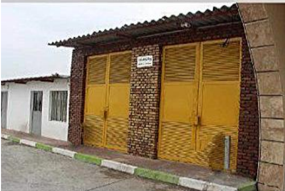
پست زمینی برق اختصاصی
